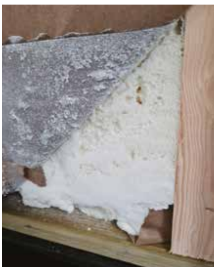
feuille de protection isolante avec mousse en totalité
